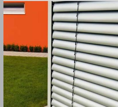
Beispiel mit geböckelter Raffstorelamelle und seitlichen Führungsschienen
